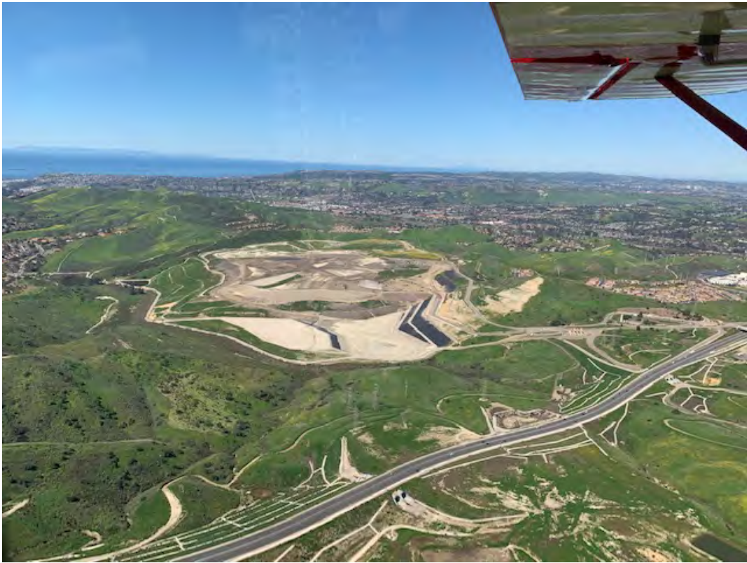
Prima Deshecha Landfill
